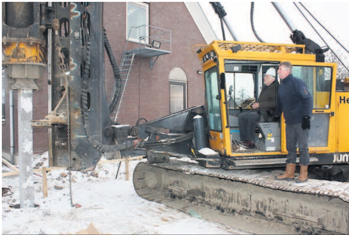
• Leo van de Beukel slaat de eerste paal van de uitbreiding van de gereformeerde kerk in Ottoland.
